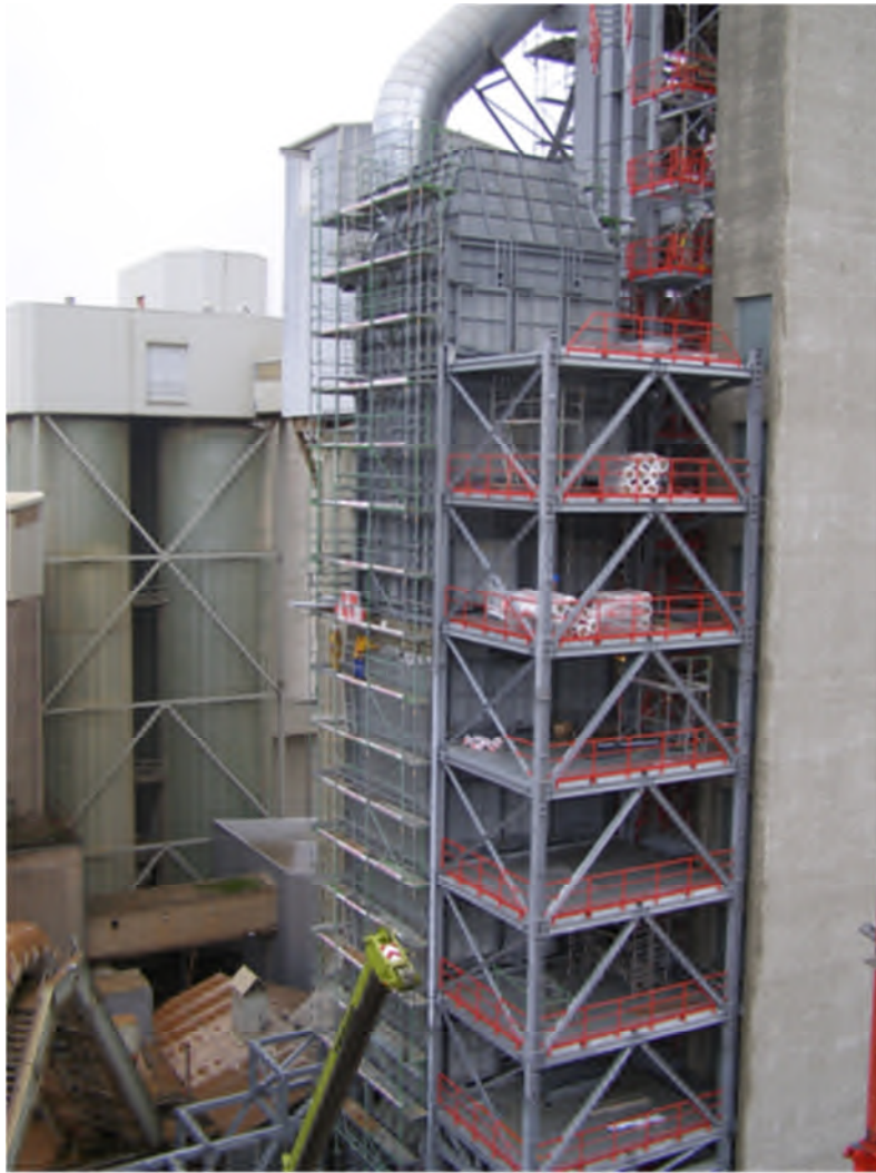
Bild 4-2 Montage des SCR-Reaktors im Dezember 2009
