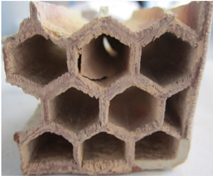
Bild 5-3 Foto eines Katalysatorelementes mit Staubbelägen innerhalb einzelner Waben (Mai 2011)
