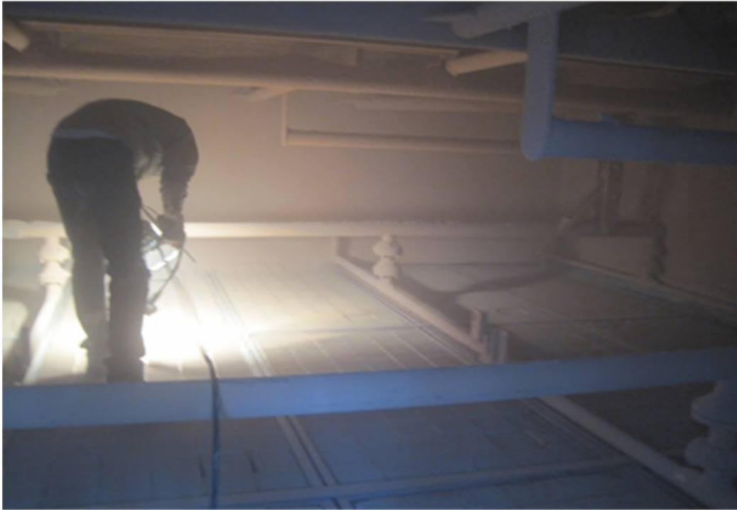
Bild 4-7 Oberfläche einer Katalysatorlage mit Druckluftbläsern während einer Inspektion
