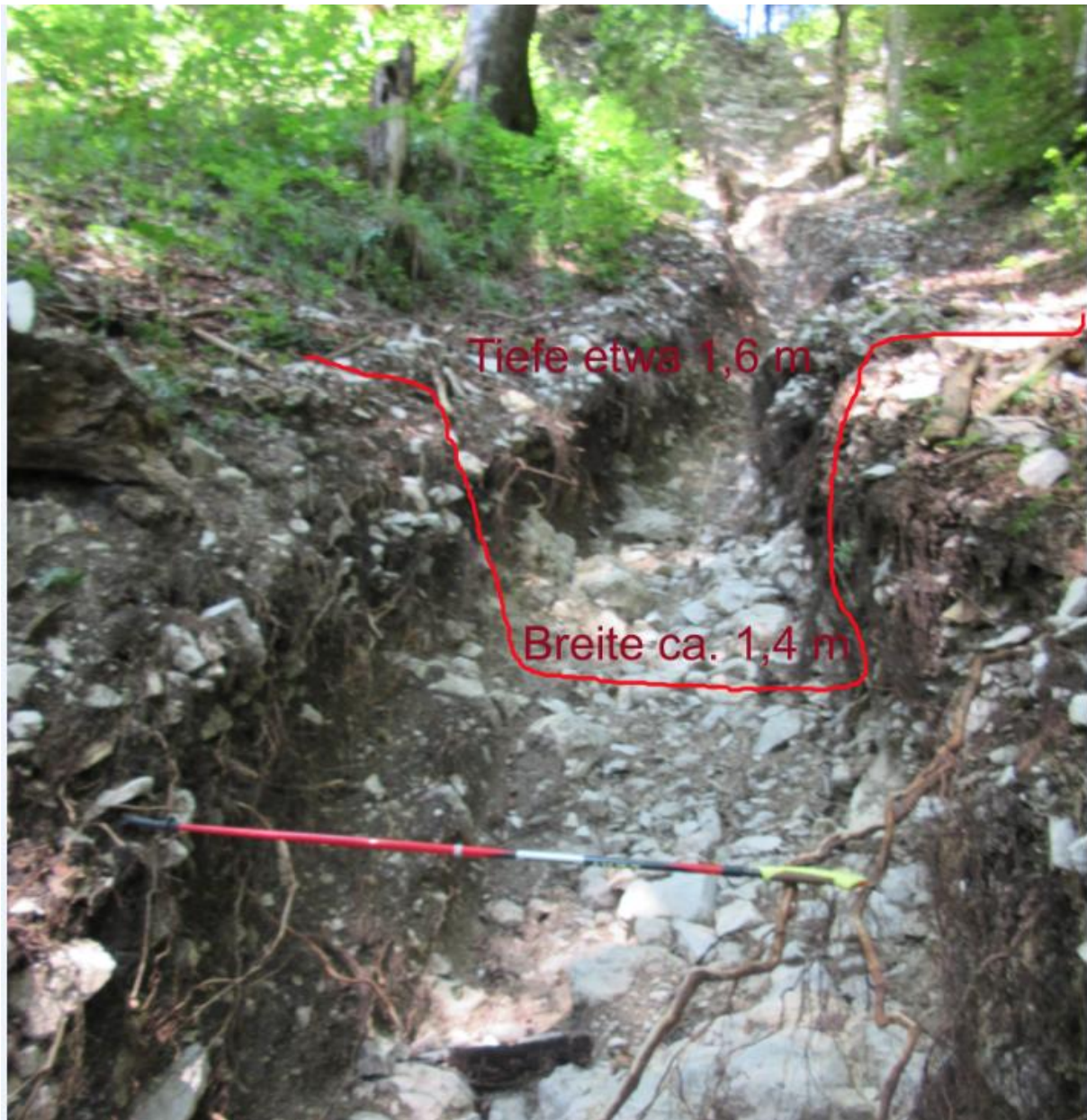
Ausgespülte Wasserrinne vom Wasser aus der im vorigen Bild aufgenommenen Oberfläche Richtung Süden.
